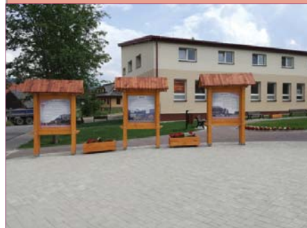
Zdravotné stredisko po rekonštrukcii a úprave na byty
